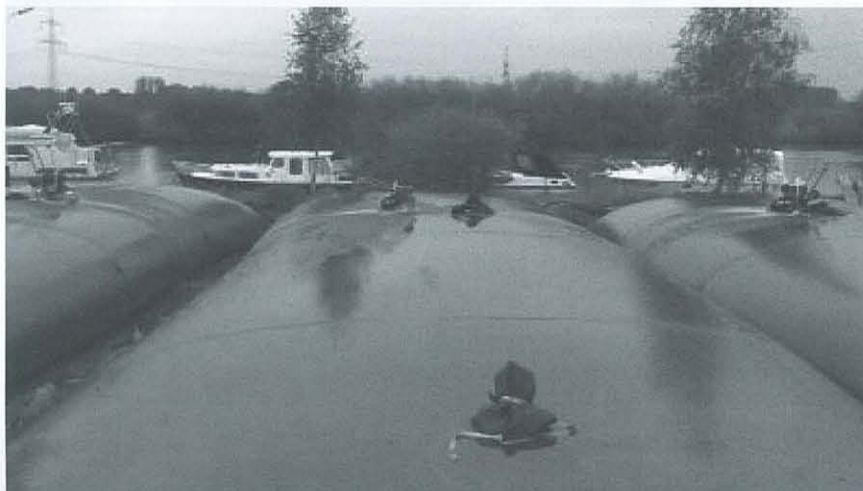
Bild 4: Gefüllter Schlauch [Foto: Matthäi]
