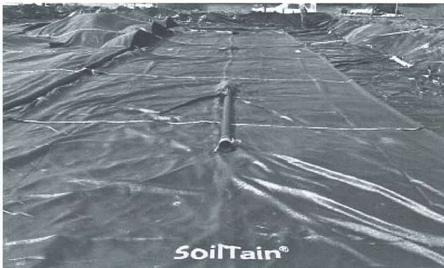
Bild 3: Ausgelegter Geotextilschlauch [Foto: Matthäi]
