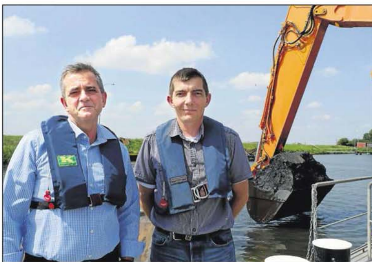
Matthäi-Geschäftsführer Bernd Afflerbach (links) und Vermesser Jörg Höfken freuen sich, dass die Baggerarbeiten in den Vorhäfen gut vorangehen. • Fotos: Raczkowski
