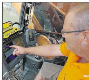
Matthäi-Mitarbeiter Sven Hartwig zeigt die Software, die ihm dabei hilft, den Kanal „blind“ auszubaggern.
