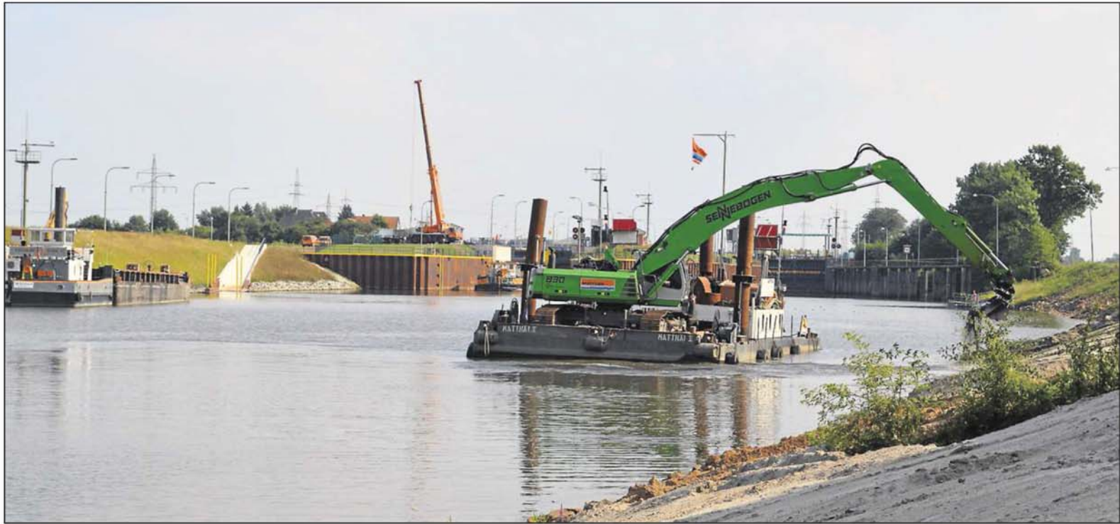
Der Stelzenponton Matthäi II mit einem 42-Tonnen-Kettenbagger bei Arbeiten im unteren Vorhafen.
