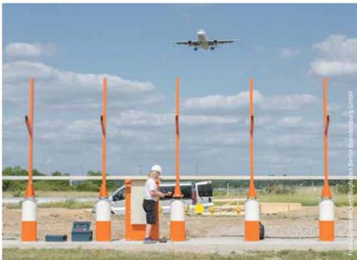
Ein Arbeiter montiert im Auftrag der Deutschen Flugsicherung die Antennen der Landekursender.
