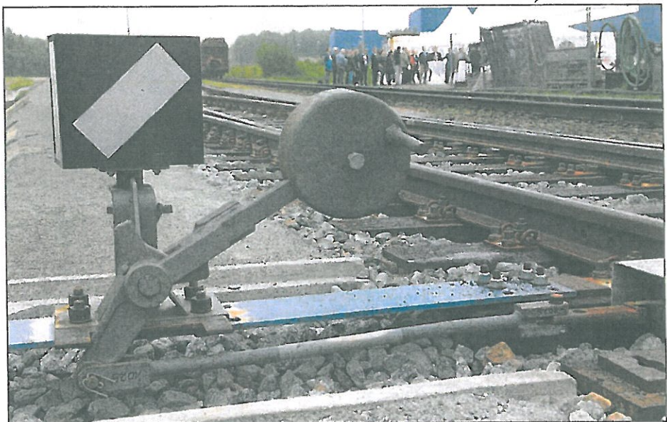
Mehr Gleis- und Rangierfläche stehen nun am Lager für Massenschüttgüter für die Abfertigung der Kohletransporte zur Verfügung.
