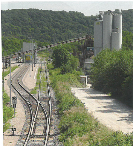
Die neue Kiesverladeanlage
