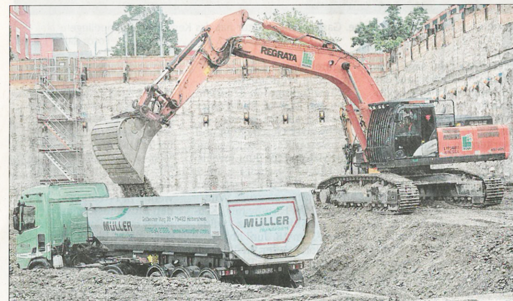
Der Erdaushub aus der Baugrube wird auf Lastwagen verladen und abtransportiert.
