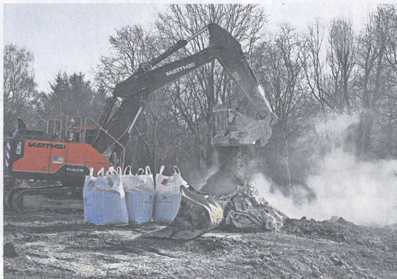
Ist der Aushub von der Tunnelbaustelle zu feucht, wird er mit Kalk gemischt . Der so verfestigte lehmhaltige Boden wird anschließend mit einer Planierraupe verteilt.
