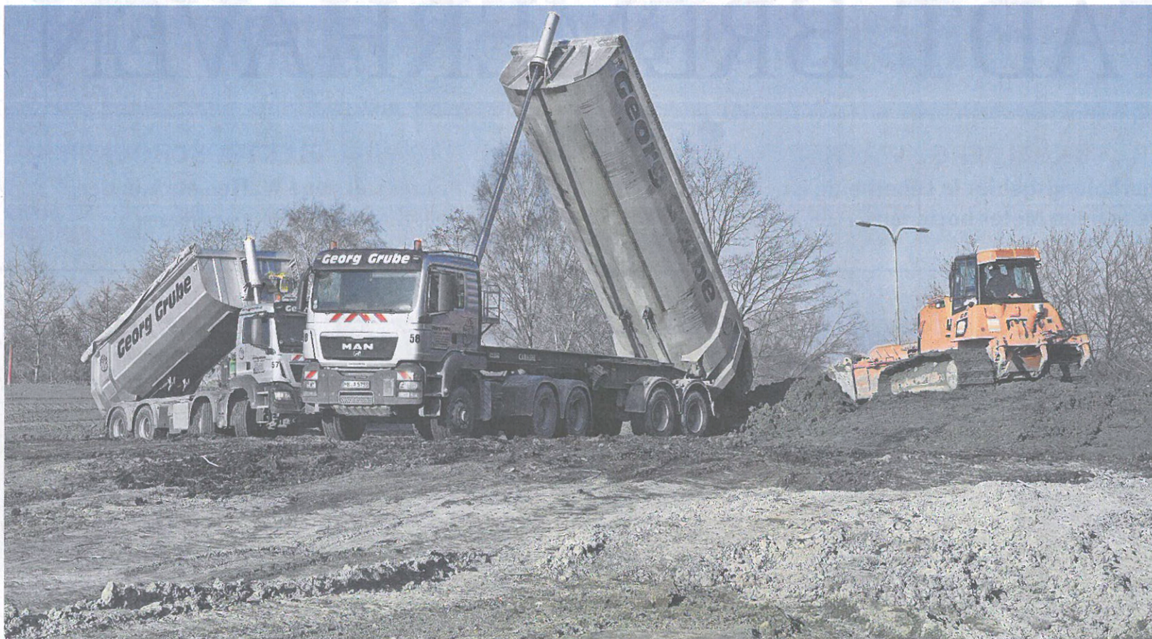
250 000 Kubikmeter Bodenaushub werden per Lkw von der Hafentunnel-Baustelle zum künftigen „Leherheider Berg“ kutschiert und abgekippt. Am Ende wird der Hügel eine Höhe von 25 Metern erreichen. Auf dem „Gipfel“ entsteht ein 1000 Quadratmeter großes Aussichtsplateau. Fotos (3) Scheschonka
