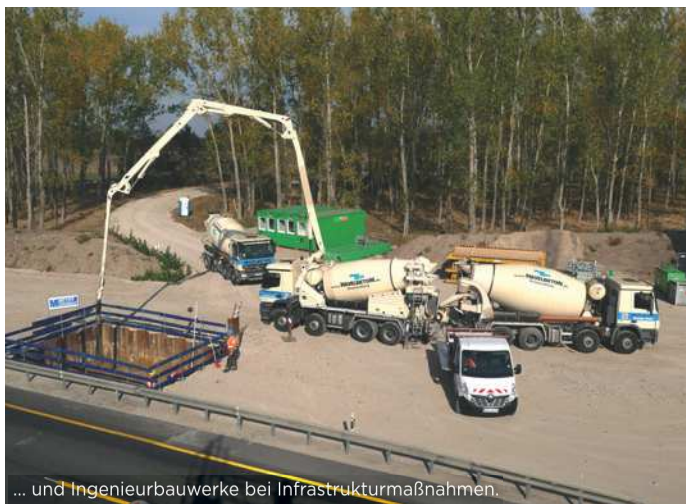
Neben Eigenheimbesitzern beliefert Havelbeton auch Industriebaustellen ...
