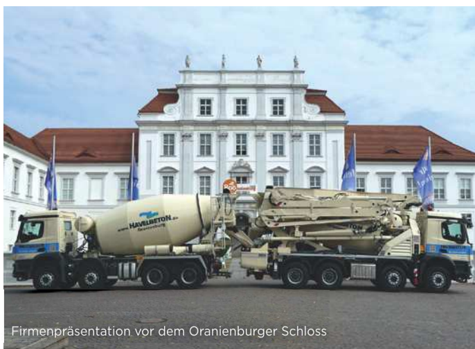
Betonanlieferung für einen Brunnen
