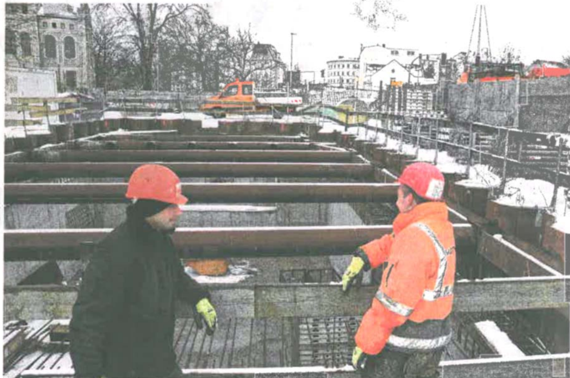
Die Bauarbeiter der Firma Matthäi haben jetzt die Stahlbetonwände des Beckens gegossen, im nächsten Monat folgt die Decke. Dann werden die technischen Anlagen eingebaut.
