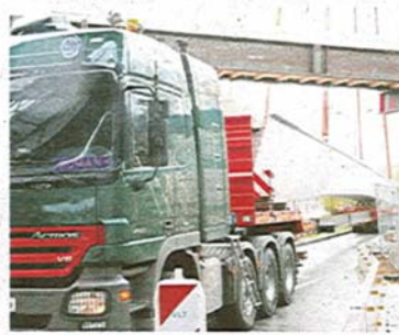
45 Meter lang sind die beiden Brückenträger, die per Lkw angeliefert wurden.
