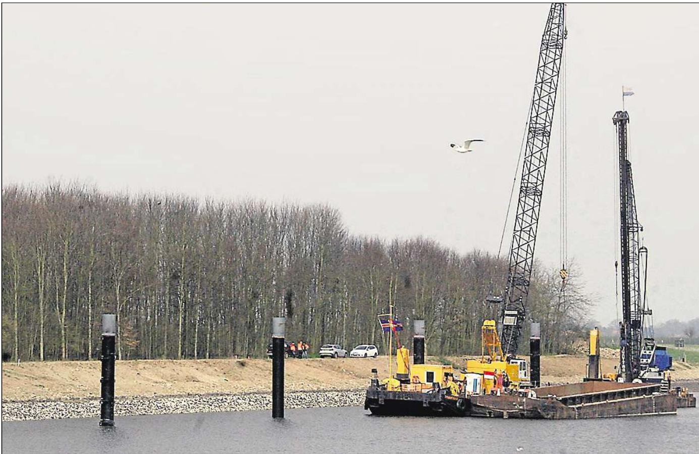
Die etwa 20 Meter langen Dalben werden 13 Meter tief in den Grund der Weser gerammt.
