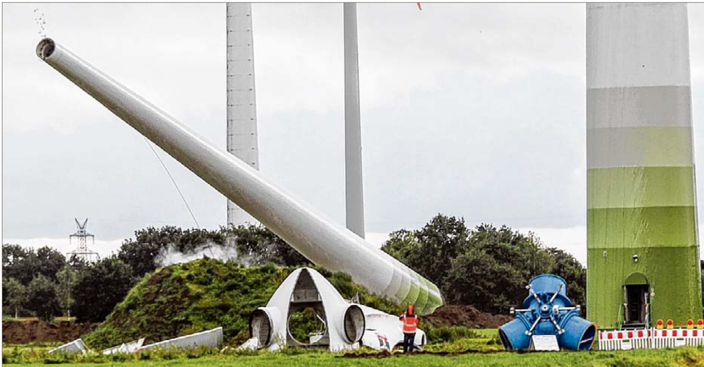
Der Turm der Enercon-E66-Anlage fiel exakt in die zuvor berechnete Richtung.
