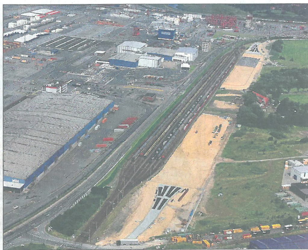
Meterdick sind die Sandberge, die auf der Hafenbaustelle am Imsumer Deich verteilt werden. Die ersten Gleise liegen bereits im Baufeld. Ende 2017/Anfang 2018 sollen auf den neuen Schienen die ersten Güterzüge rollen. ■ Foto: Bremenports/Scheer
