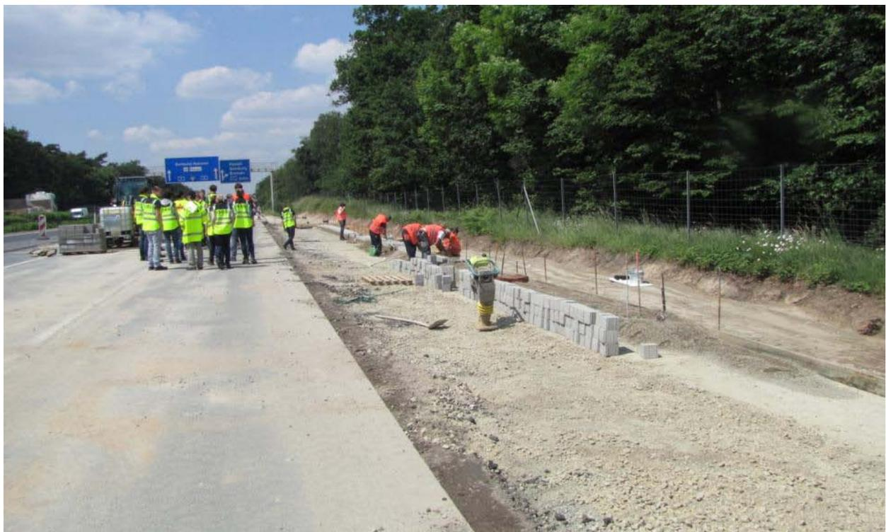
Abbildung 1. Bauarbeiten an der Entwässerungsmulde auf der A2 am Kreuz Hannover-Ost.
