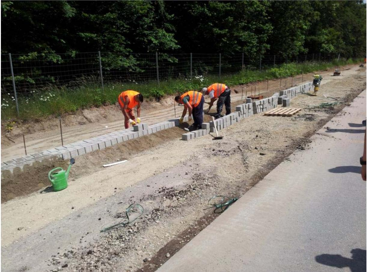
Abbildung 2. Pflasterung der Entwässerungsrinne.
